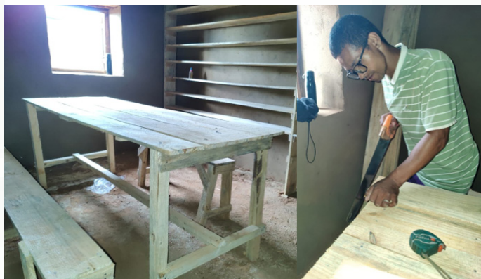
Tojo legt selbst Hand an beim Einrichten eines neuen Büros
