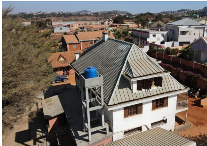
Der Tank des neuen Wasserturms versorgt uns nun zuverlässig mit Wasser
